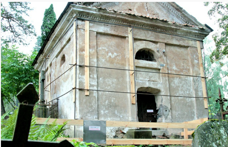
Kaplica św. Wincentego także została zabezpieczona, do ścian przymocowano żelazne rury, które mają je wzmocnić Fot. Marian Paluszkiewicz
