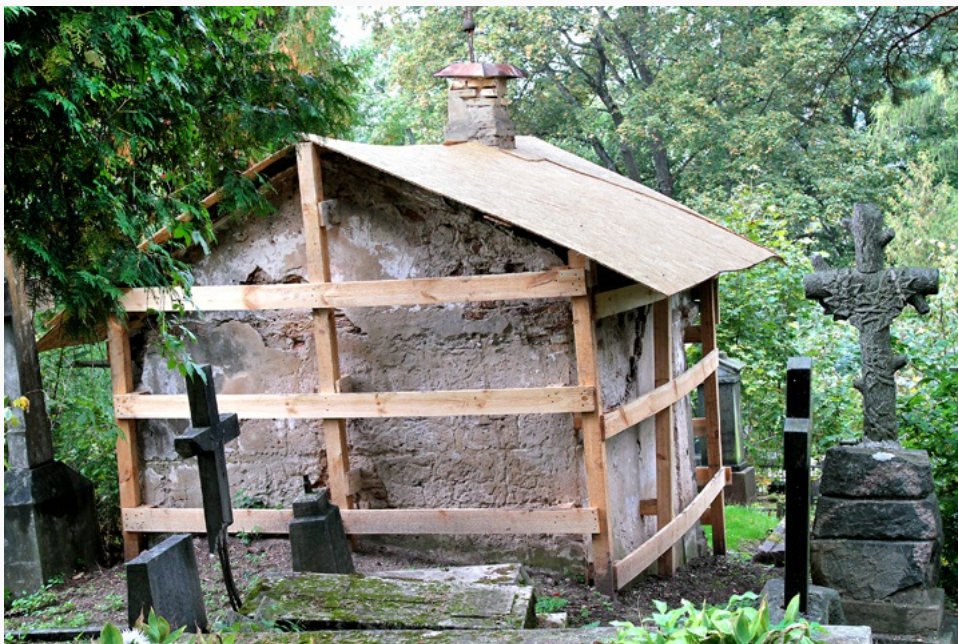
Ściany kaplicy Ogińskich zostały wzmocnione, trochę naprawiono dach, żeby nie upadł Fot. Marian Paluszkievicz
