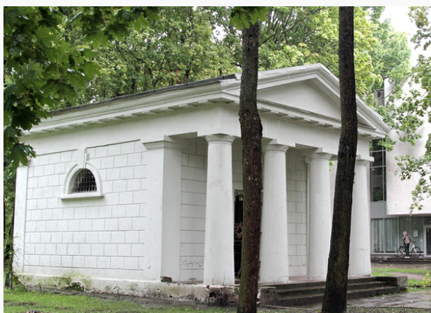
Jedyną pozostałością architektury cmentarza ewangelickiego jest kaplica grobowa Nizzkowskich Fot. Marian Paluszkiewicz
